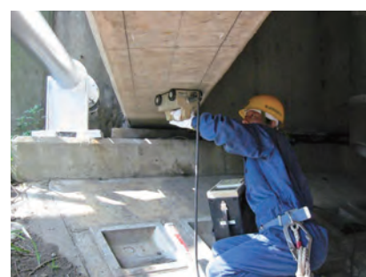
① 鉄筋探査
