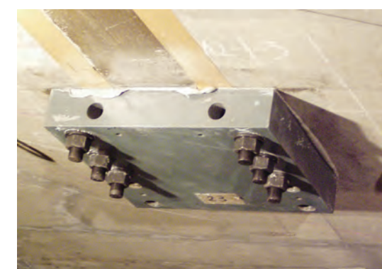
③ 定着用固定プレート取付
