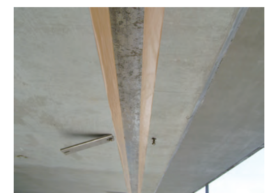
④ 接着面プライマー塗布
