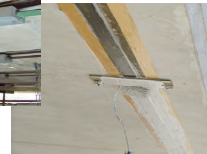
⑦ アウトプレート仕上げ塗装
