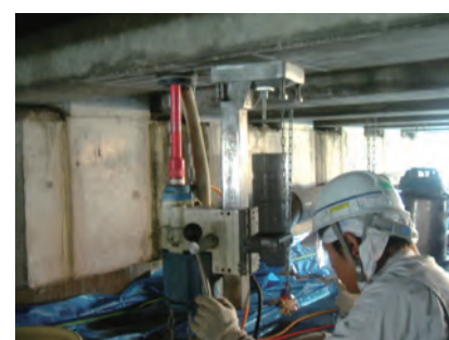
② 定着アンカー削孔
