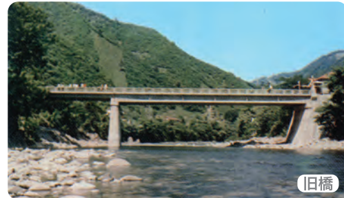
当社本州地区初の工事竣工橋梁です。新波形鋼板ウェブ橋(写真下)が架設されました。この写真では旧橋(下写真奥)が写っています。
