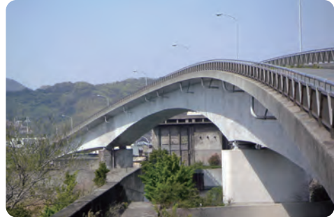
当社単独初の張出施工橋梁です。縦断勾配10%、平面線形500mの厳しい条件です。
