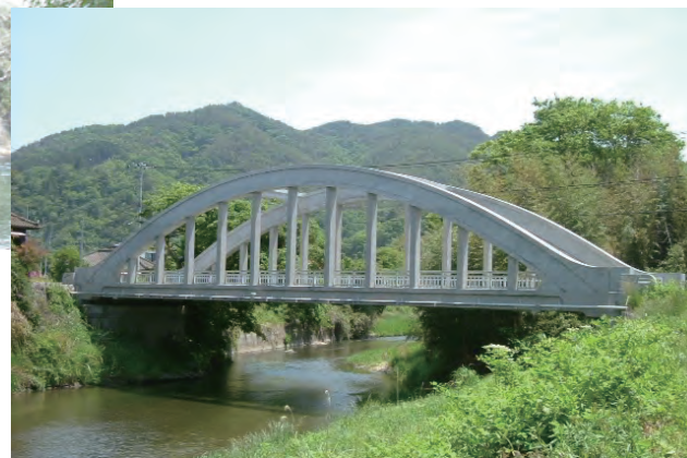
山倉橋（鋼橋） 形式：アウトプレート 場所：千葉県市原市 発注者：千葉県
